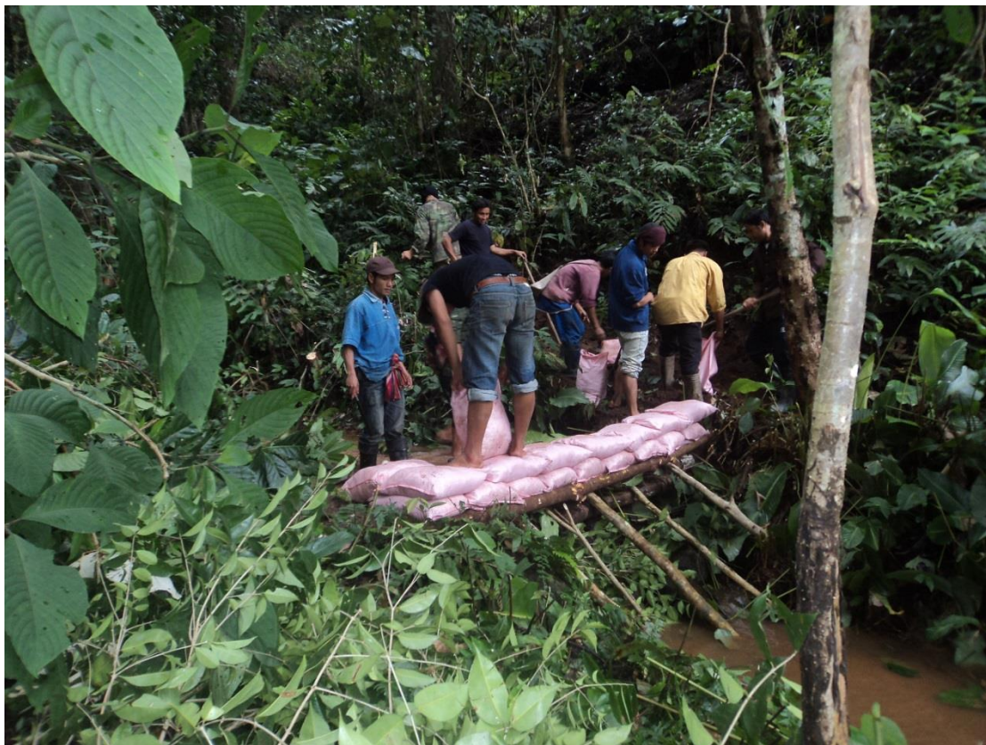
กิจกรรมทำฝายกั้นน้ำไว้ใช้ในฤดูแล้งเป็นประจำทุกปี ณ. ขุนต้นน้ำแม่ลอง
