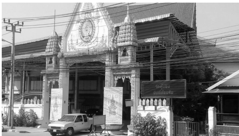
แผนภาพที่ ๒.๒ ซุ้มประตูทางเข้าวัดคูบอน
