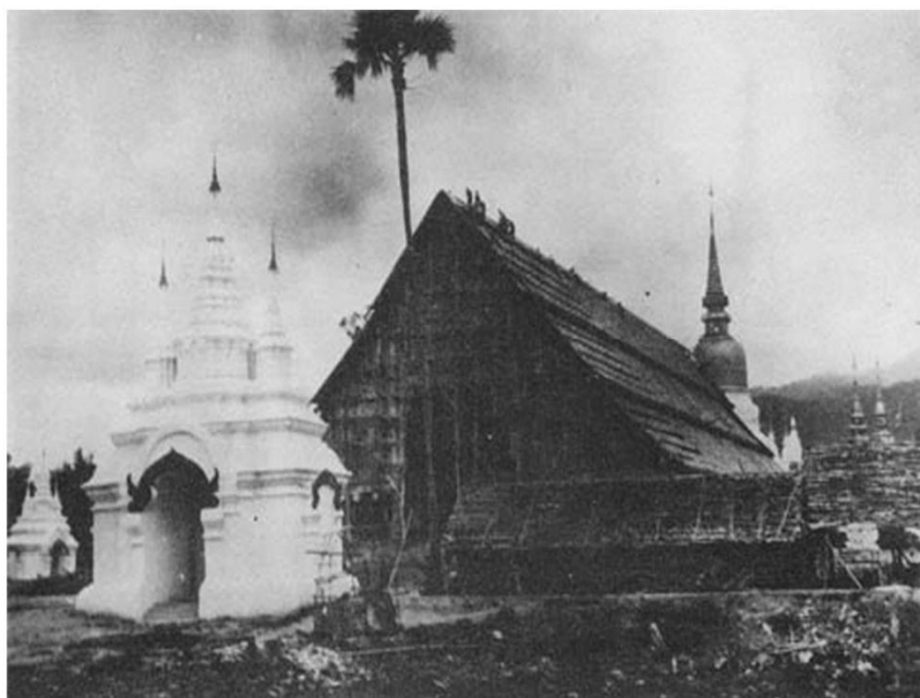
ภาพถ่าย ขณะกำลังบูรณะปฏิสังขรณ์วัดสวนดอก เชียงใหม่
