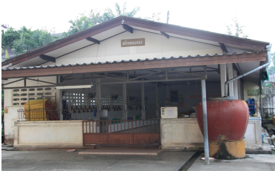
อาคารหอฉัน
